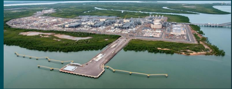
Ichthys LNG project - Darwin
